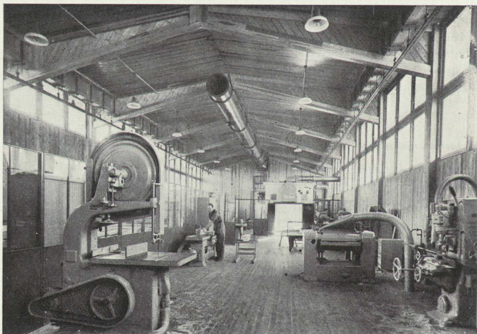
Interiör av maskinhallen vid träforskningsinstitutets trätekniska avelning.
