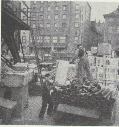
Sanitets- och rörgods avlastas för hand från lastbil och upplägges på kajen under och invid den flyttbara kranen tillsammans med möbler...
