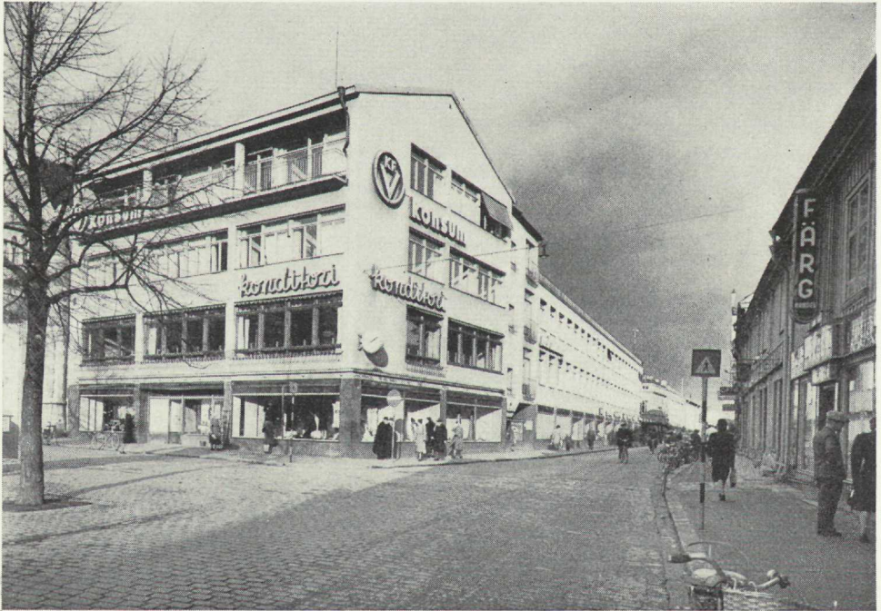
Enstaka fastigheter i city som utnyttjas för kommersiella ändamål kan med ny bebyggelse ofta förränta tomtvärden som avsevärt överstiger värdet av närbelägna tomter.
