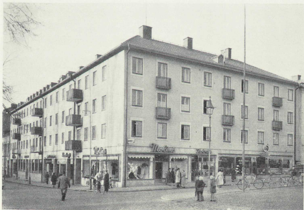
Kvarteret Åberg i Uddevalla före och efter sanering. Även om den befintliga bebyggelsen har en stor volym kan sanering av fastigheter med förmånligt affärsläge löna sig ur privatekonomiska synpunkter.
