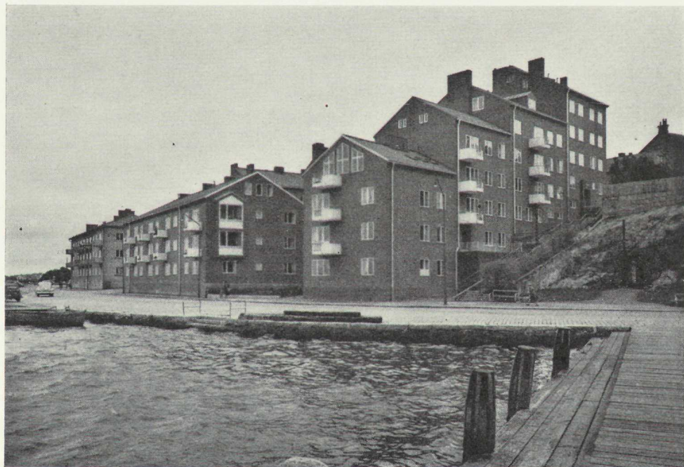
Kvarteret Cederström i Karlskrona efter kvarterssanering. Saneringen har genomförts av ett enskilt företag.
