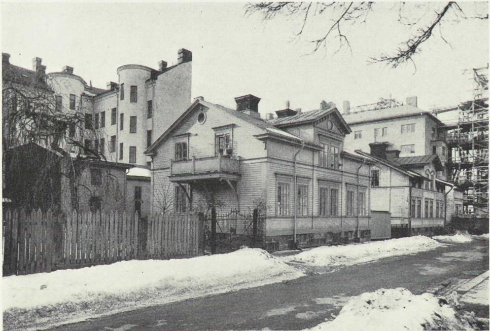
En rationell sanering av ett område som detta bör omfatta även den höga gårdsflygeln till vänster på bilden. Om detta innebär att företaget som helhet blir förlustbringande kan subvention vara motiverad.
