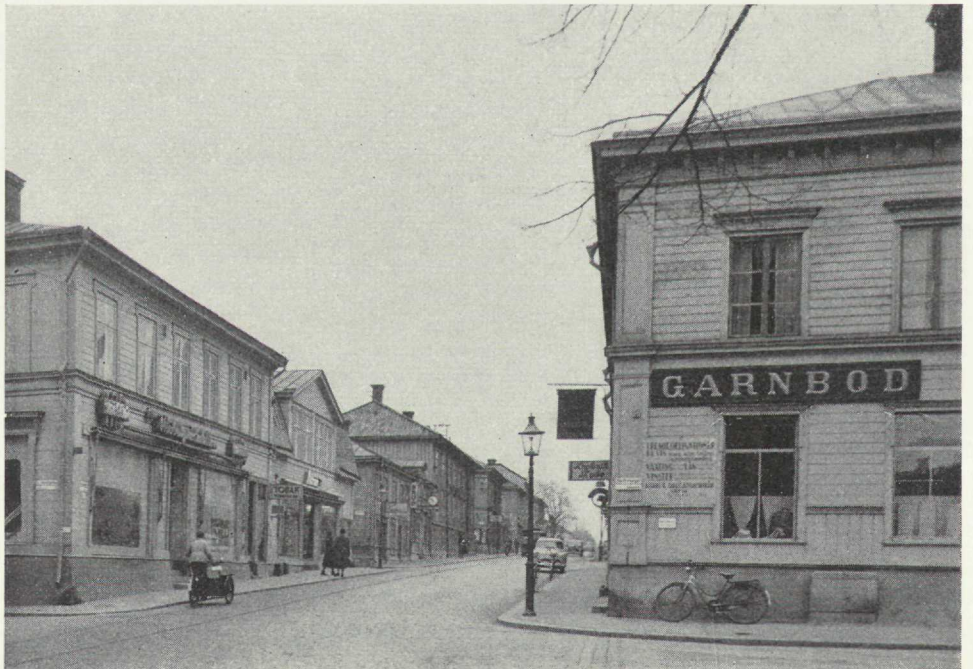
Denna gata skall breddas längs ena sidan. Huset till höger kommer att rivas och lämna rum för en trafikplats. Då de planerade förändringarna måste ske i ett sammanhang torde bestämmelserna i 44 § byggnadslagen om zonexpropriation kunna tillämpas.
