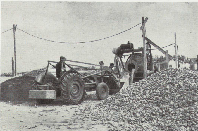
Fig. 4. Fergusontraktör i betongstation.
