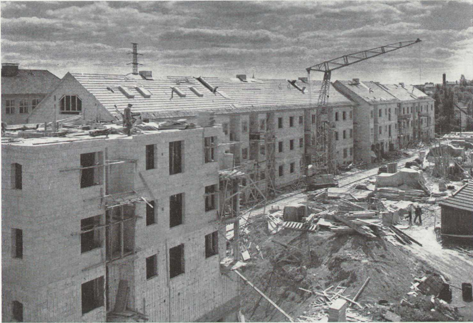
Bild 712. Lättbetonghus under byggnad.
