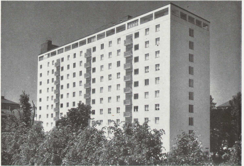
Bild 713. 12-våningshus av putsad lättbetong.
