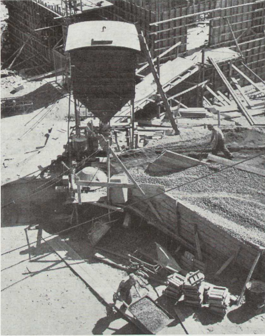
Fig. 5. Betongblandare. Gruset framdrages med handskrapspel.
