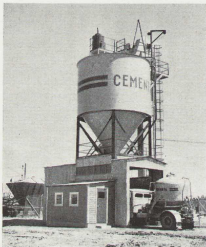
Bild 314. Silo för löscementutlastning.
