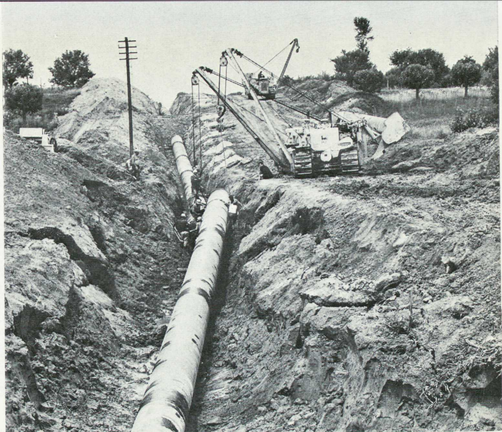
Bild 8: 1 Den projekterade rörledningen för olja förlägges under jord. Bilden visar nedläggning av rör för den Trans-Alpina råoljeledningen (TAL).
