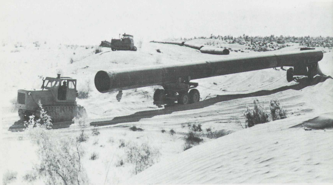
De 36 meter långa och 1 420 mm grova rören forslas genom Karakum-öknen väster om Kaspiska Havet till bygget av gasledningen Sjatlyn-Chiva.
