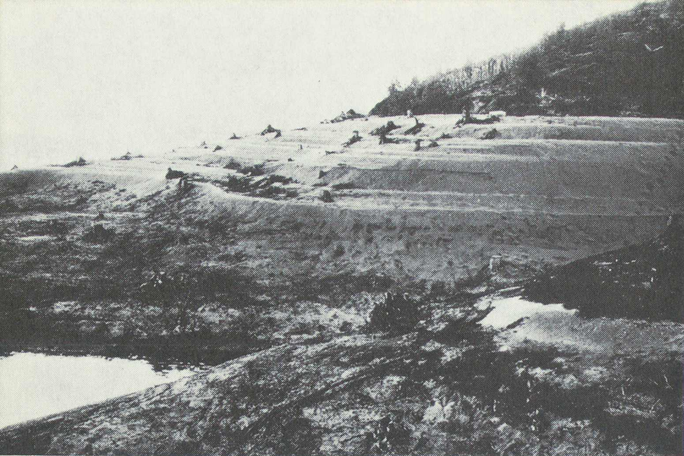
Fig. 1.10 Ett tomt magasin är ingen tilltalande syn. Ovanför dämningensgränsen högst upp på bilden är terrängen och vegetationen ännu oförändrad, utan strandkarkatär, nedanför har karaktären starkt förändrats genom erosion och terrassbildning. Ljusnan, Lossenmagasinet. Foto Ake Sundborg 1969.
