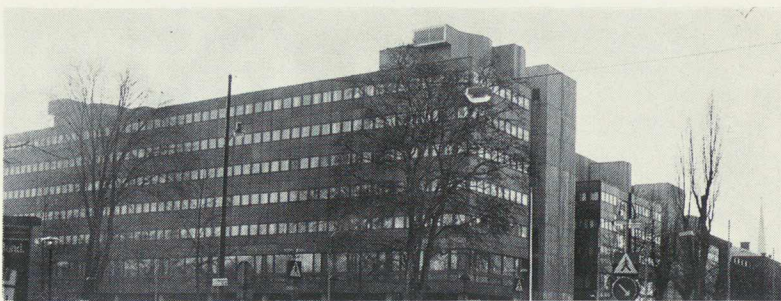
8b Fotografi på den färdiga byggnaden.
