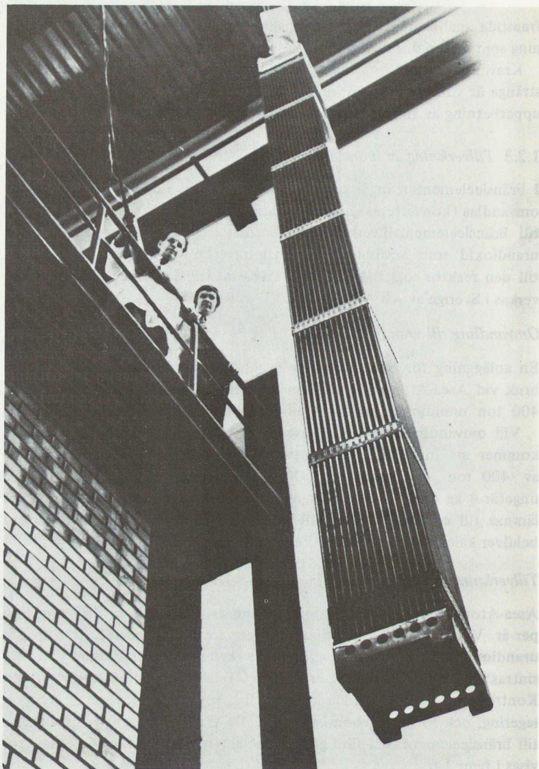
Figur 1.6 Bränsleelement för tryckvattenreaktor
