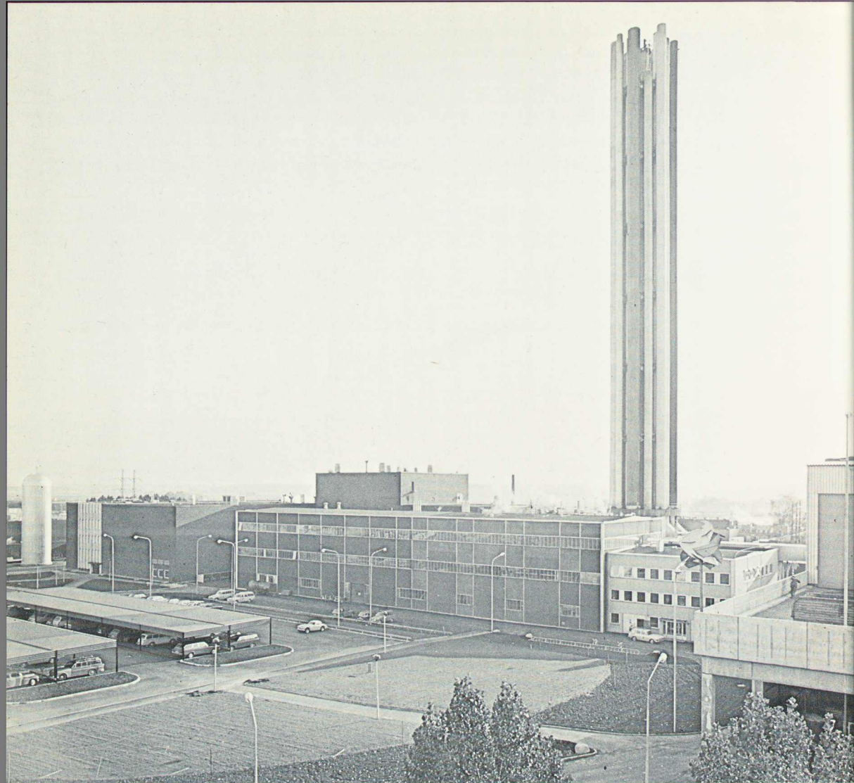
Figur 17. Uppsala kraftvärmeverk. Verket har en kapacitet av 200 MW eleffekt och 315 MW värmeeffekt. Den senare motsvarar värmebehovet för drygt 40 000 normallägenheter. Av hänsyn till stadsbilden är anläggningen delvis nedsänkt under markplanet. Den 100 m höga skorstenen med 10 st rökgaspipor betjänar även en hetvattencentral och en sopförbränningsanläggning.
