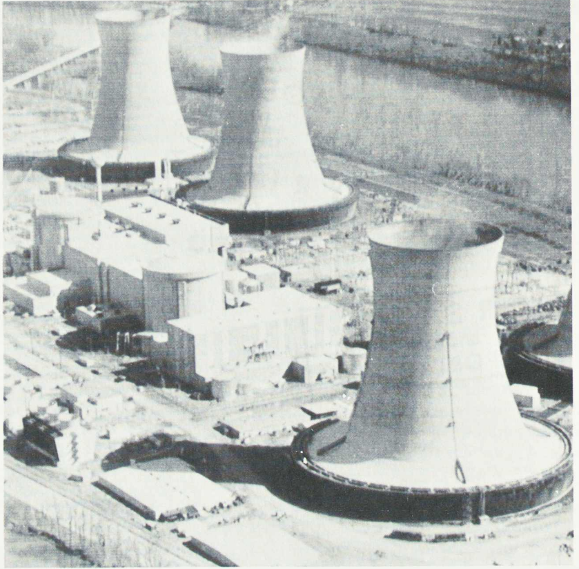
Kärnkraftverket Three Mile Island utanför Harrisburg, Pennsylvania, USA. Den hitre högra av de runda byggnaderna i mitten är inneslutningen till den havererade reaktorn TMI-2.
