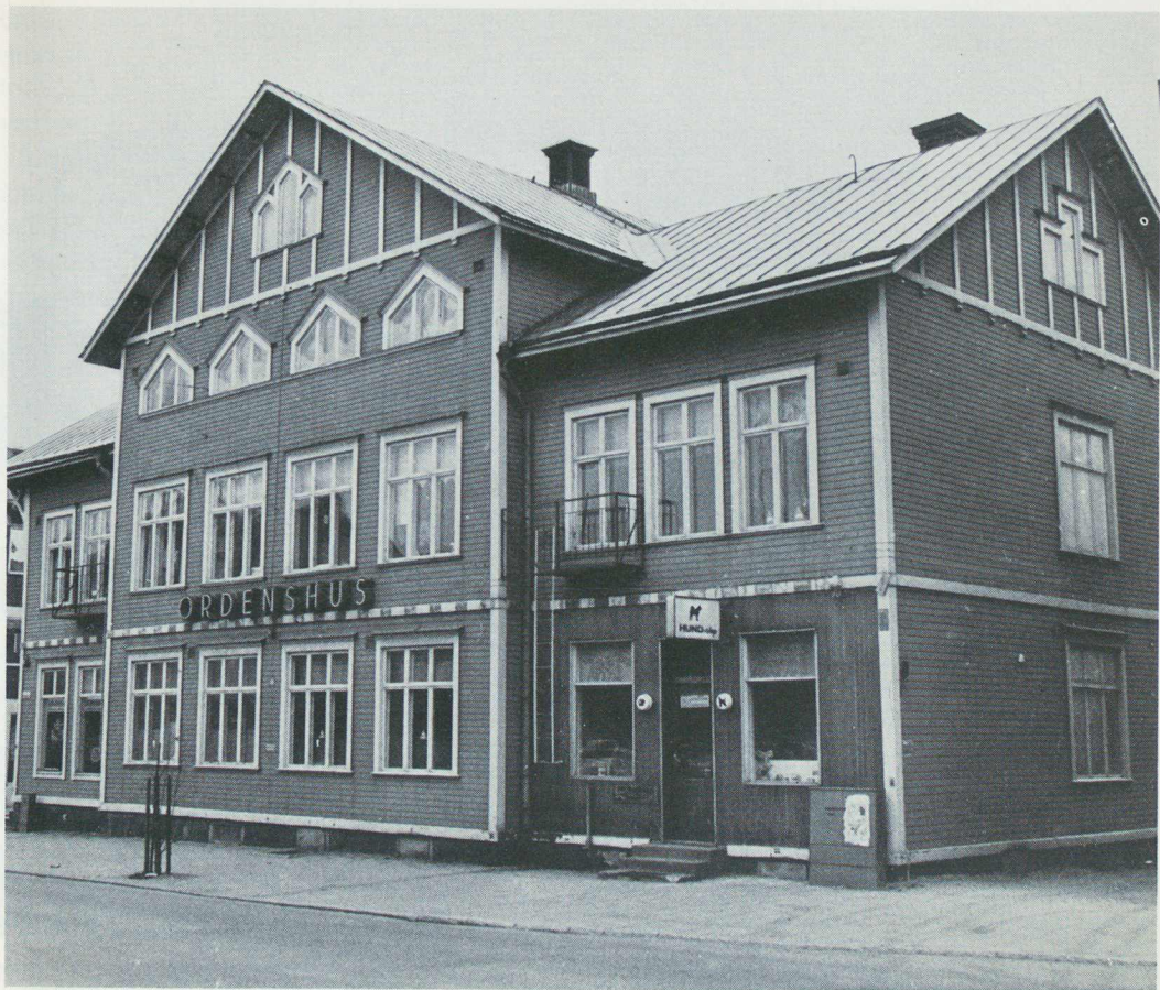
Ordenshuset, Umeå kommun. Upprustning planeras.
