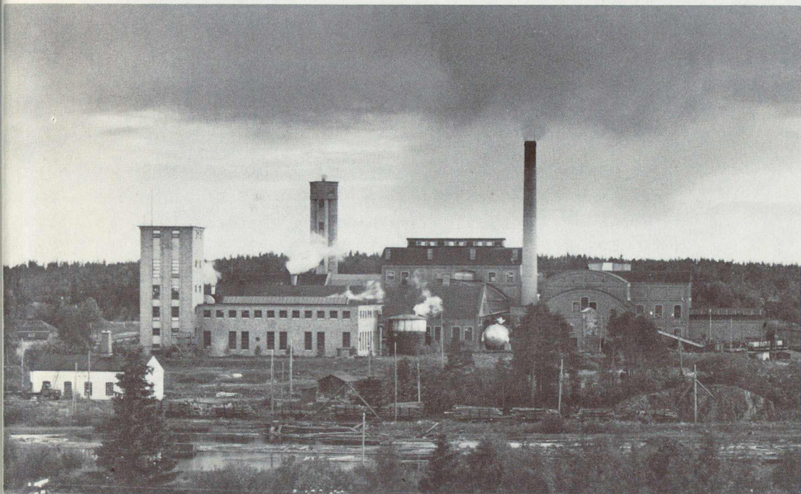
Figur 3. Sulfitfabriken i Robertsfors strax före nedläggningen 1948.
