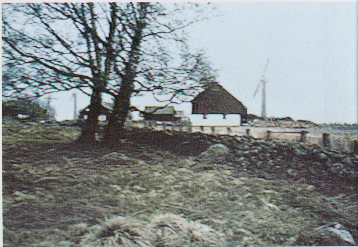
Figur 25 Gruppstation med fem aggregat, två dolda. Avstånd till kraftverken, från vänster: 1 200, 850 och 650 meter
