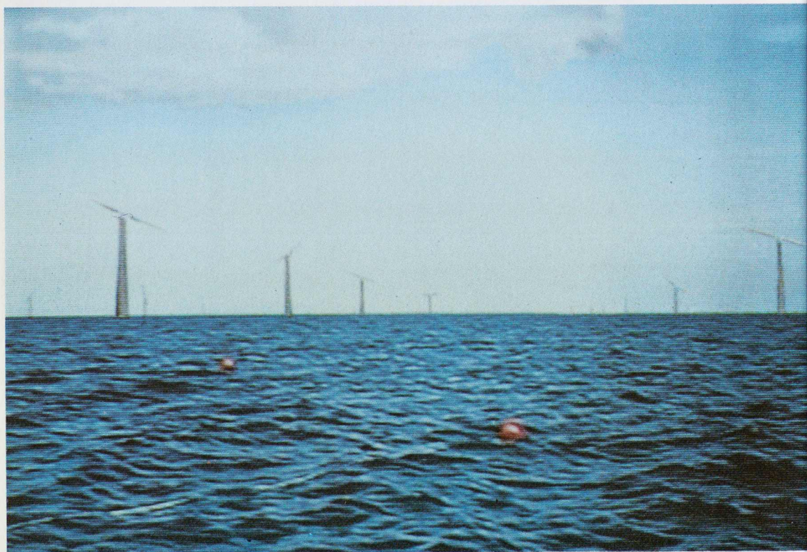
Figur 27 Gruppstation med 100 aggregat. Avståndet till närmaste vindkraftverk är 700 meter. Inget av de vindkraftverk som syns i bilden ligger längre bort än 5 km
